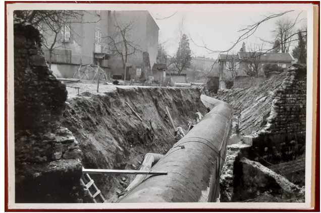
23/03/1971 : partie aval du collecteur, depuis le pont SNCF
