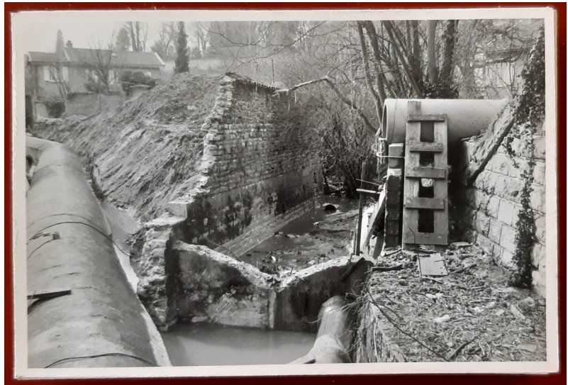
15/03/1971 : vue de l'ancien ruisseau [qui subsiste quelques temps après]
