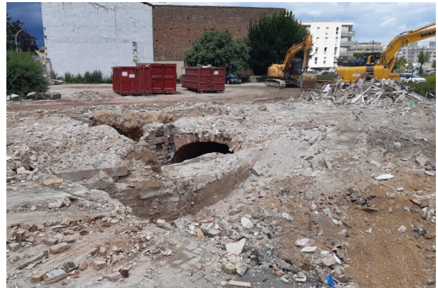
Mise au jour des anciennes canalisations en juin 2024 (fonds personnel)
