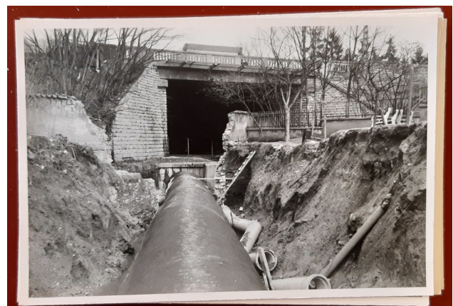
[23/03/1971] : vue du premier tronçon aval avec raccord sur pont SNCF
