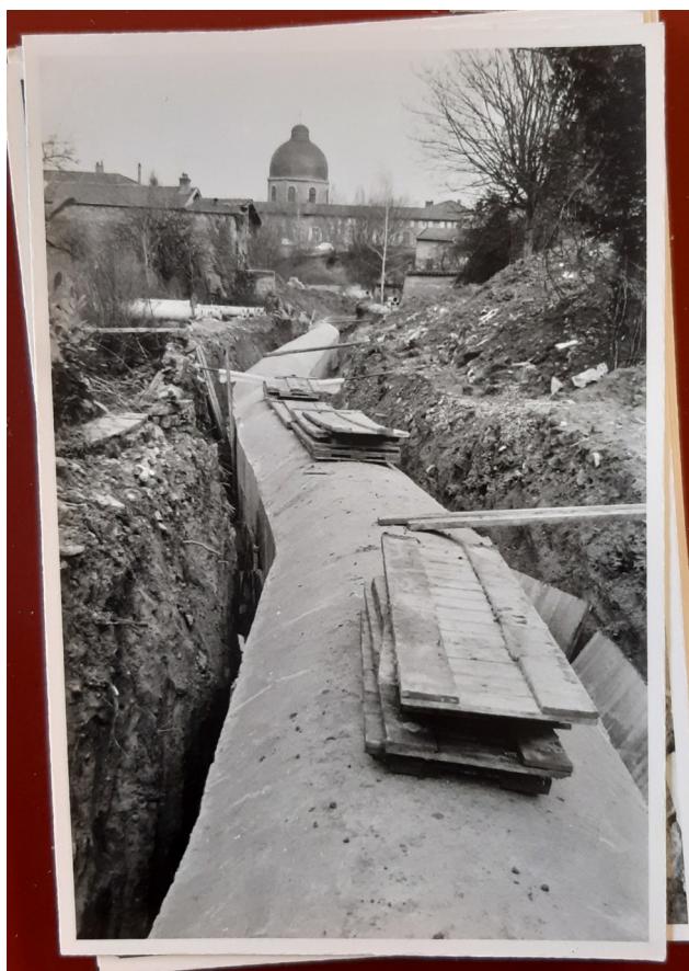
23/03/1971 : vue du chantier en regardant vers le nord, depuis propriété Goyon
